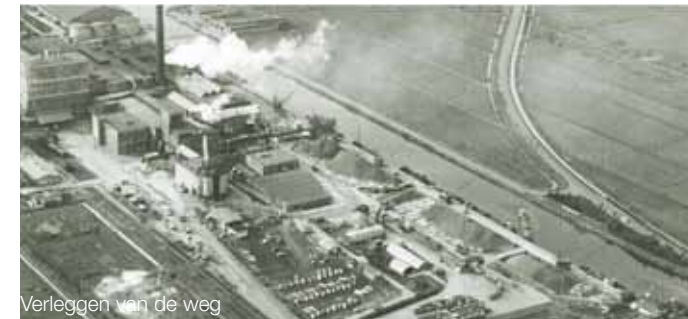
Verleggen van de weg
